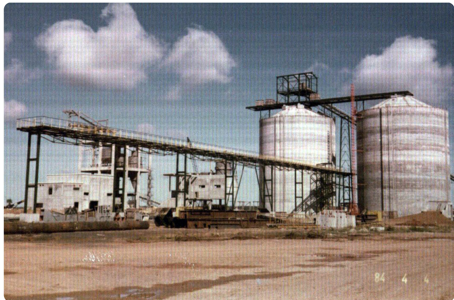
Silos de clinker Fábrica Villeta Año 1984
