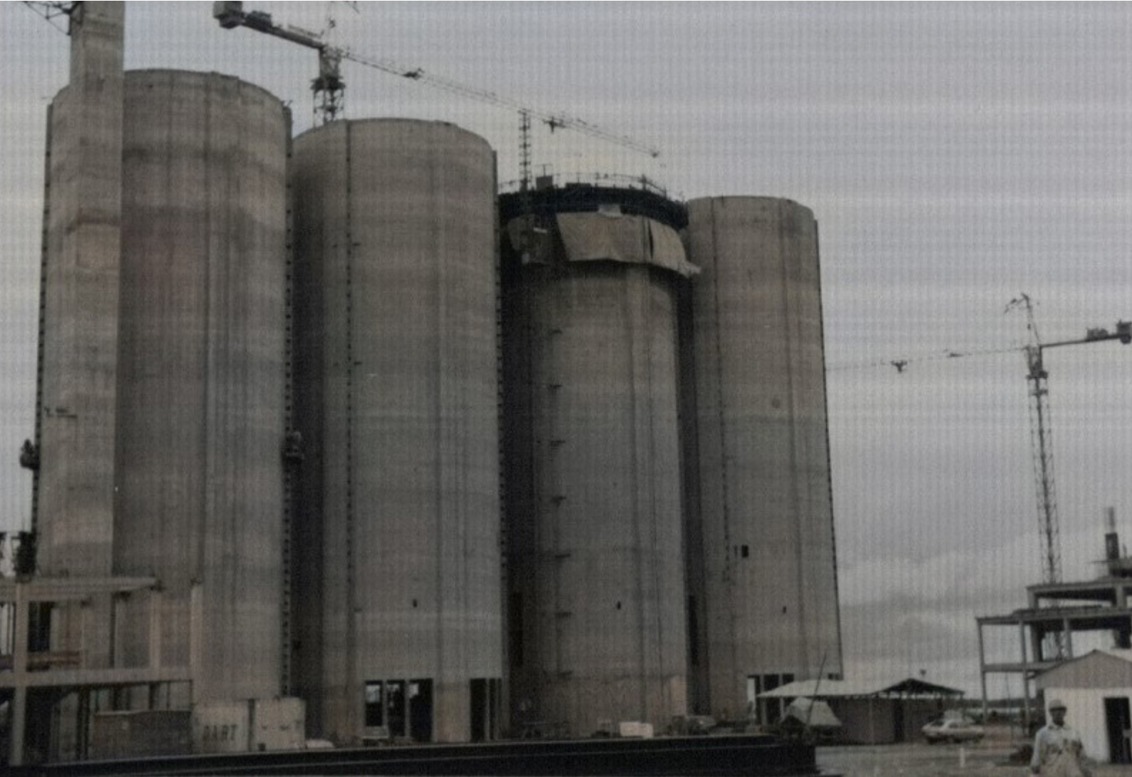
Silos de Cemento Fábrica Villeta
