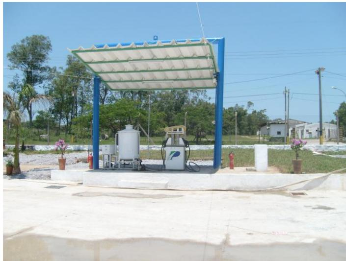
Cuenta con un tanque subterráneo para combustible con una capacidad de 20.000 litros en el predio fabril. La ubicación del mismo permite una disminución de los costos para la empresa, por el menor recorrido que realiza las máquinas (camiones tumbas, palas cargadoras, topadora, tractores) para la provisión del combustible (diesel), esto es teniendo en cuenta la ubicación anterior que se encontraba a una distancia mucho mayor, con el consecuente sobre costo.
