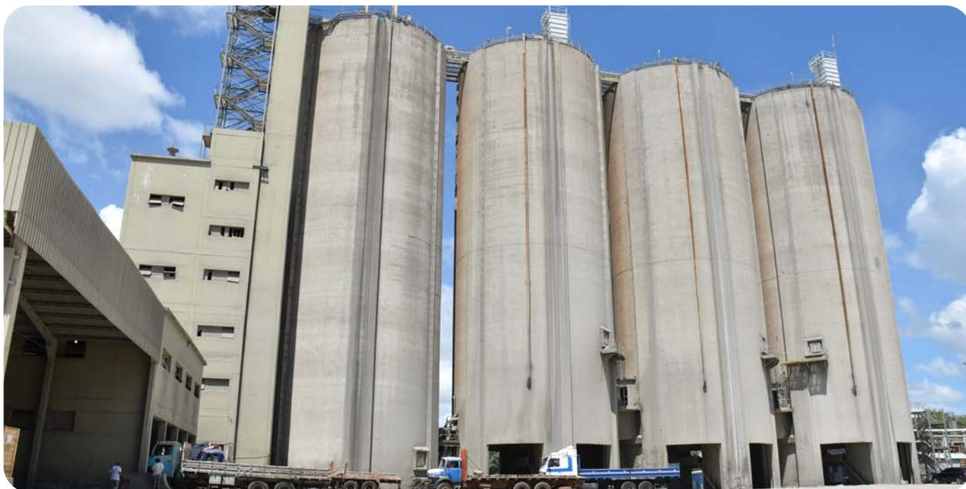
**Silo 1.** Vaciamiento, desmontaje, reparación y montaje de ductos y fluidificadores, bocas de extracción, guillotinas, roscas, etc. (después de más de 10 años).
