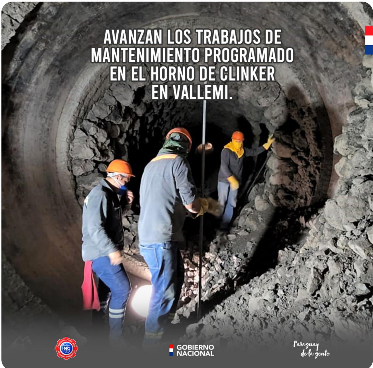
El horno opera a muy altas temperaturas y para garantizar su buen funcionamiento, la INC realiza un mantenimiento preventivo cada año, tanto del horno, como de toda la línea de producción de Clinker. Consiste en cambiar los ladrillos refractarios del horno que se desgastan hasta alcanzar su espesor mínimo. Los trabajos duran entre 35 a 45 días. ¿Afecta la fabricación y provisión de cemento?
